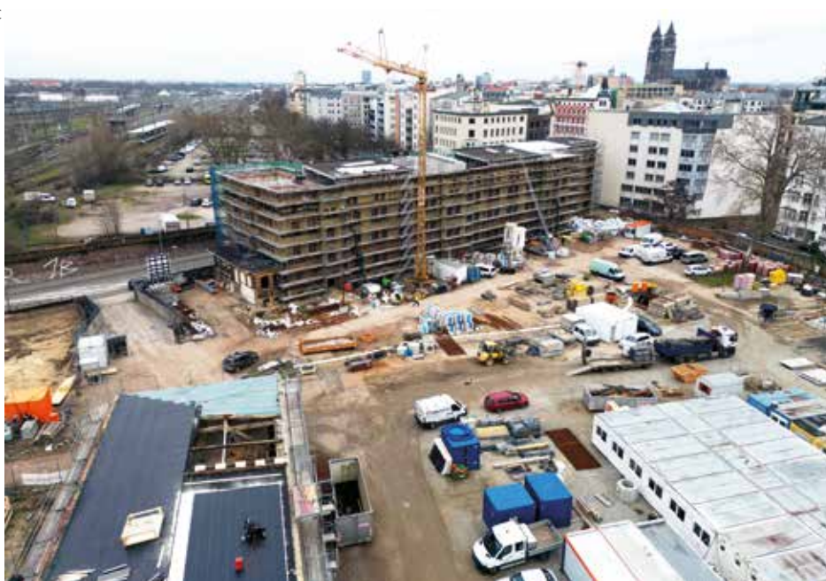
Großbaustelle der „neuen“ Liegenschaft PI MD am Hasselbachplatz in Magdeburg
